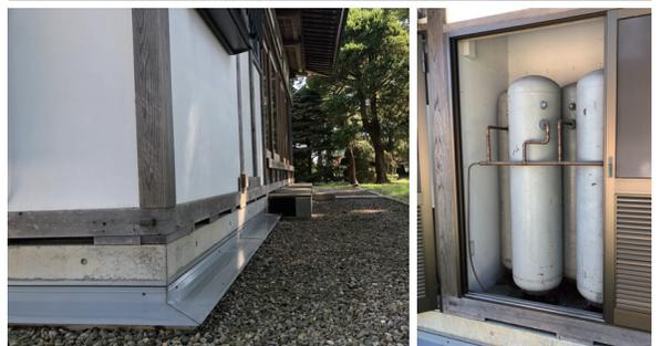
▲古民家は 235 m<sup>2</sup>、総重量 180 t の大型物件だが、地震を感じるとエアータンクから空気を送り込まれ、3センチほど建物が浮上
