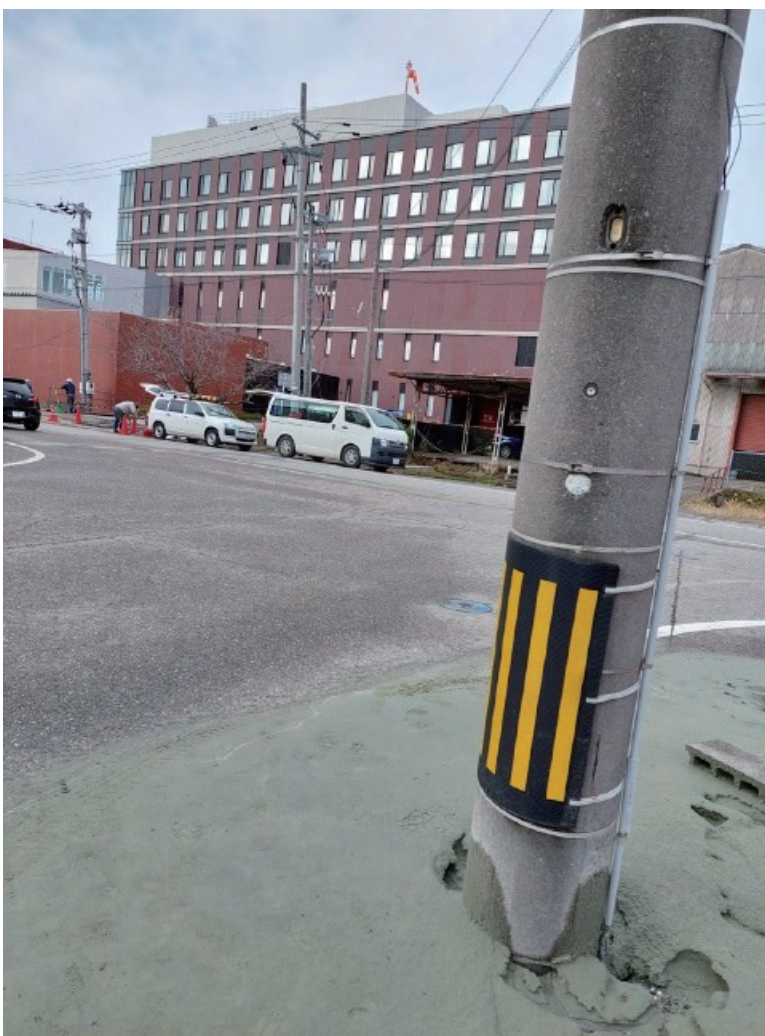
▲恵寿総合病院では免震構造の本館は地震被害を免れたが、周辺では地割れや段差が発生している
