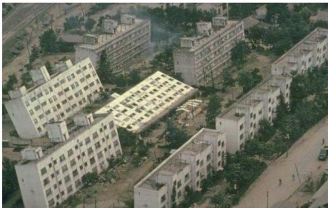
左の写真は、1964年6月16日に新潟県の粟島南方沖約40kmを震源としたマグニチュード7.5の地震により倒壊したアパート群です。最大震度5とそれほど大きくない地震にもかかわらず、鉄筋コンクリート造4階建てのアパートが原形を留めたまま横倒しになりました。この原因は地面の液状化によるものでした。液状化とは、地震の震動により地下水位の高い砂質土の地盤が液体になる現象で、噴水、噴砂、地盤沈下、マンホールの浮き上がり、建物の傾斜、沈下、倒壊をもたらすものです。
