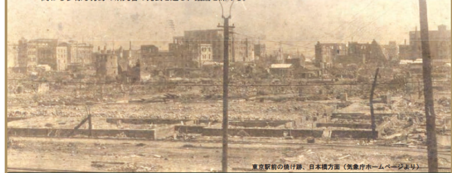
東京駅前の焼け跡、日本橋方面 (気象庁ホームページより)
