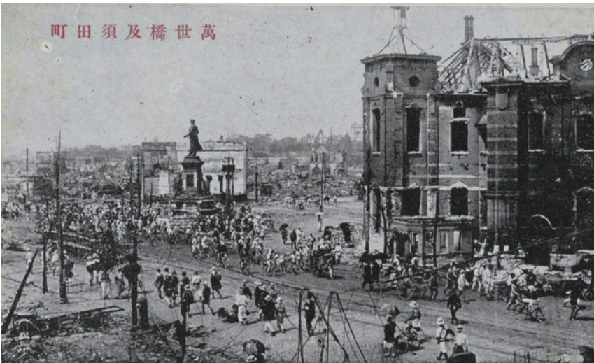
▲関東大震災後の万世橋、神田須田町付近の惨状 (写真提供：東京都立図書館)
