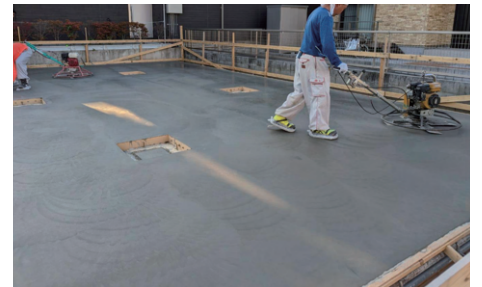
▲エアー断震装置施工のため人工地盤をピカピカに磨き上げる
