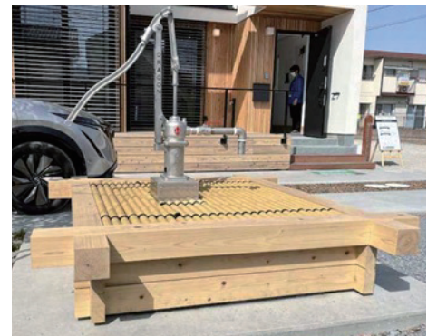
▲電気でも、手動でも利用できるハイブリッド型の井戸
