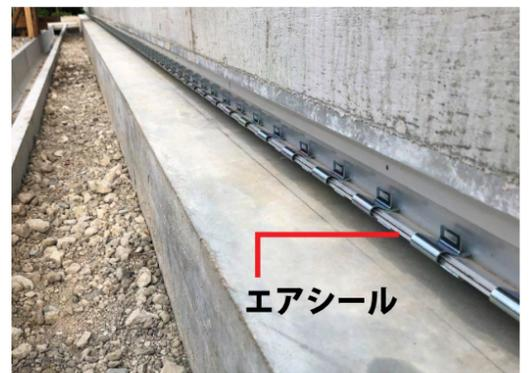
エアシールを専用の金具で留めつけて設置していく。等間隔に金具でしっかりと固定された状態、設置完了
