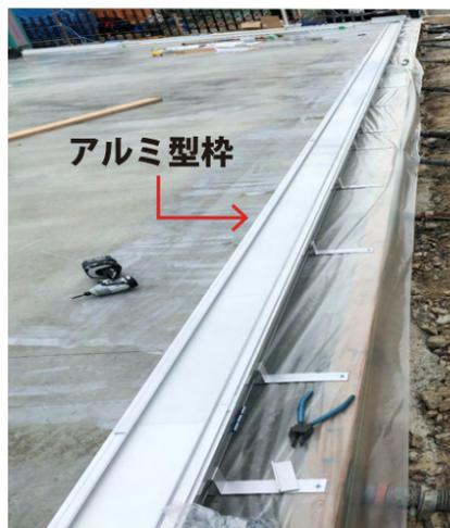
システムの鍵となるエアシールは、人工地盤と基礎の間に挿入します。エアシールの取り付けは建築の最終工程になり、アルミ型枠はその土台となるものです。これまで型枠は鋼製で重量が大きいなどの欠点がありましたが、材質をアルミに変更することで部材を一体化し軽量化でき、施工の効率が向上し施工時間が大幅に短縮されました。
