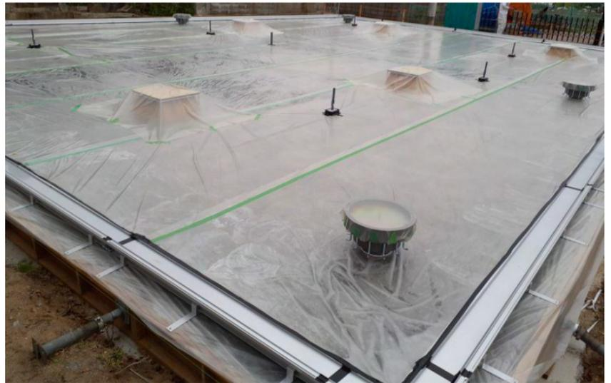
設置されたアルミ型枠。この養生で隠れた装置はリセッターとバルンサーです。バルンサーは浮上中の建物の傾きを制御し、安定性を確保する役割。リセッターは人工地盤と建物基礎との位置ずれを修正し、元の位置に戻すための装置です。
