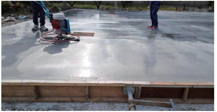
ベタ基礎と同じ要領で鉄筋を組み、コンクリートを流し込みます。「パワートロウエル」という特殊な機械を使って鏡面仕上げをしていきます。この鏡面仕上げは、空気を密封するために欠かせない作業となります。通常の住宅建築にはない作業ですが、1日で完了します。
