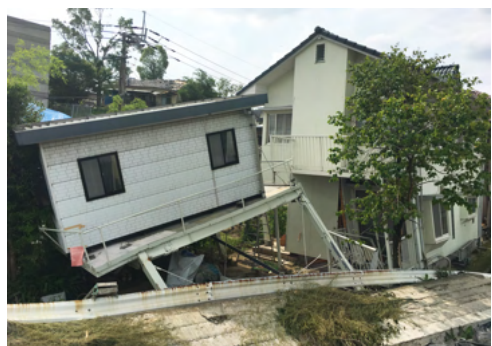
▲地震で1階が潰れた住宅
