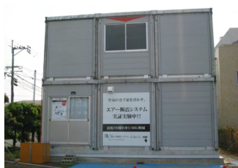
▲急遽建設した熊本市内のエアード断震システムの試験棟
