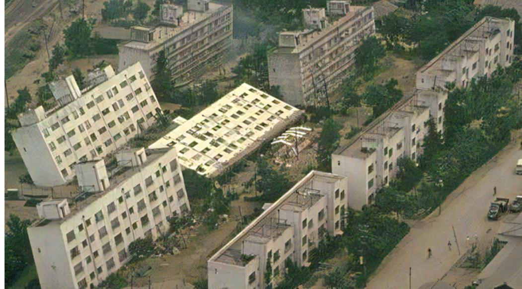
写真は、1964年6月16日に新潟県の粟島南方沖約40kmを震源としたマグニチュード7.5の地震により倒壊したアパート群です。最大震度5で、それほど大きくない地震にもかかわらず、鉄筋コンクリート造4階建てのアパートが原形を留めたまま横倒しになりました。この原因は地盤の液状化によるものでした。液状化とは、地震の震動により地下水位の高い砂質土の地盤が液体ようになる現象で、噴水、噴砂、地盤沈下、マンホールの浮き上がり、建物の傾斜、沈下、倒壊をもたらすものです。国土交通省がまとめた「液状化による被害と地震後の生活に及ぼす影響例」では、液状化の被害と復旧に関して下表のようにまとめています。本年1月1日の能登半島地震でもこの現象が約2000箇所発生し、建物、道路などへの被害を大きくしました。建物自体を耐震化していても、地盤の液状化により傾いたり、沈んだり、倒壊することもあります。どのような対策が必要なのでしょうか。
