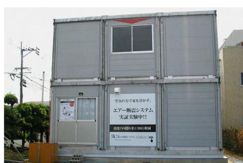
急遽建設した熊本市内のエア断震システムの試験棟
